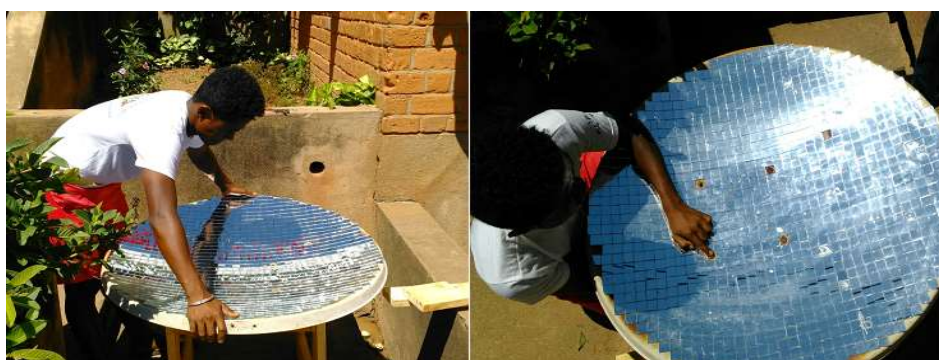
Figure 29 : Mise en place du concentrateur solaire sur le support.
