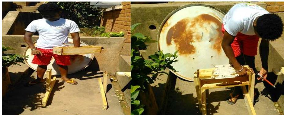
Figure 28 : Support en pied en bois, traverses et fixateur.
