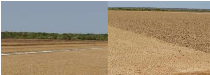
Figure n°4 : Assec, chaulage et pulvérisation de la plateforme
