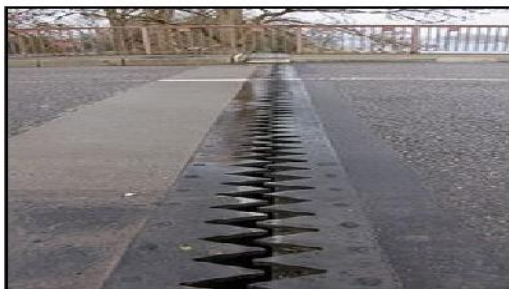
joint de dilatation d'un pont
