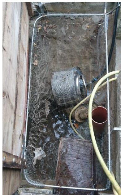
Figure 14: Dessableurs entre la prise d'eau et le bassin d'accumulation
