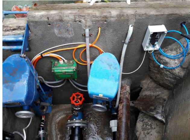
Figure 63: Emplacement du parafoudre
