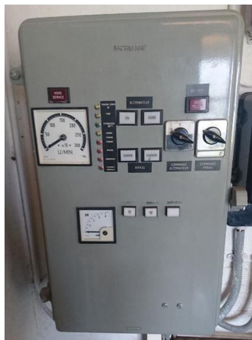
Figure 34: Tableau de commande de la turbine 3
