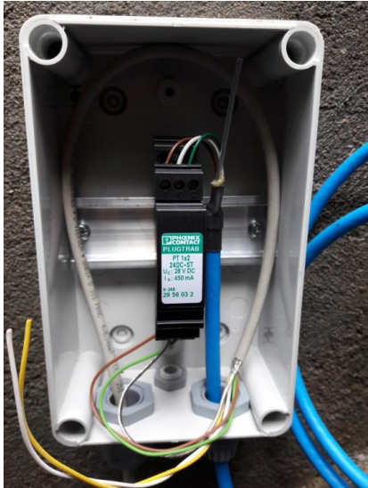
Figure 62: Parafoudre au bassin d'accumulation
