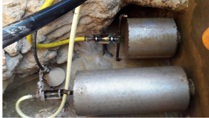
Figure 15: Dégrilleurs dans le bassin
