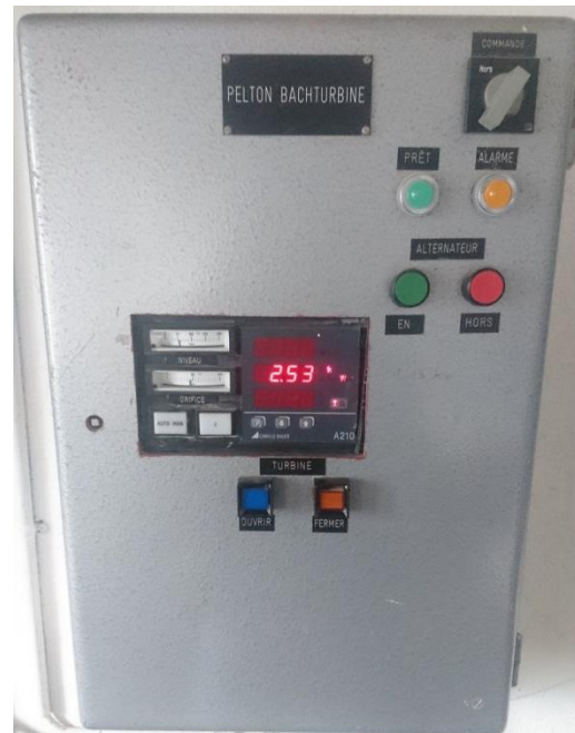
Figure 36: Tableau de commande de la turbine 4
