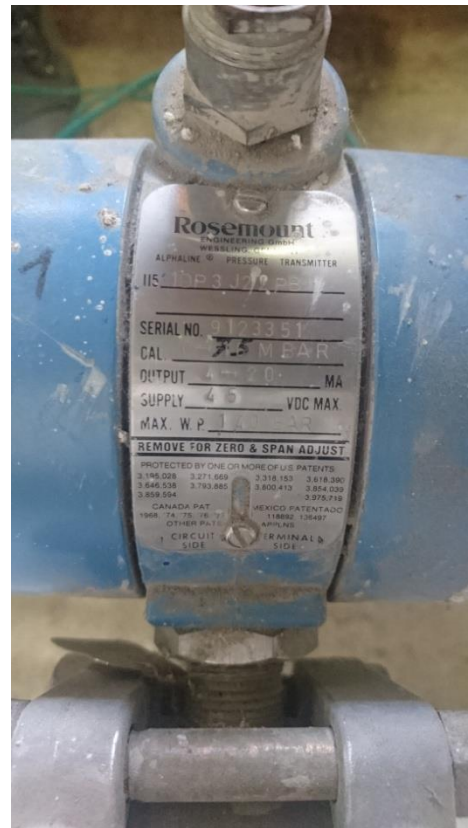
Figure 82: Mesure de débit avec pression différentielle dans le local de turbinage
