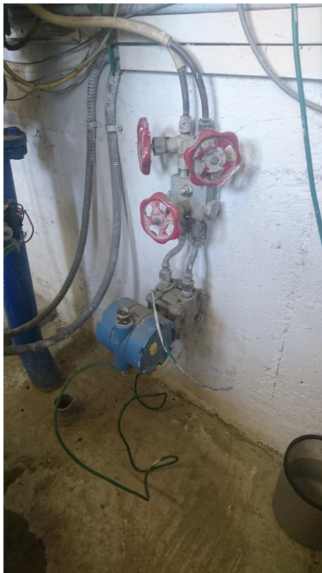
Figure 82: Mesure de débit avec pression différentielle dans le local de turbinage
