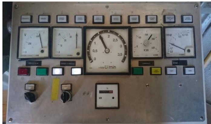
Figure 29: Tableau de commande de la turbine 1
