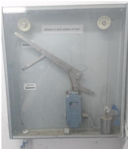
Figure 37: Mesure de niveau par flotteur
