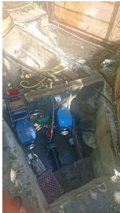
Figure 20: Bassin d'accumulation
