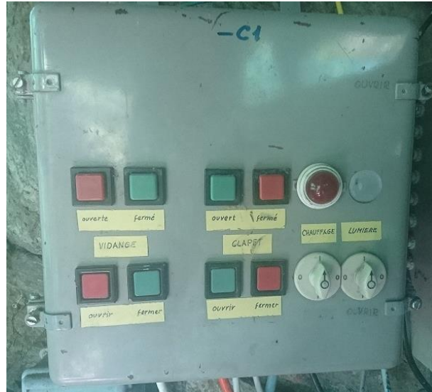
Figure 21: Tableau de commande dans le couvert à coté du bassin
