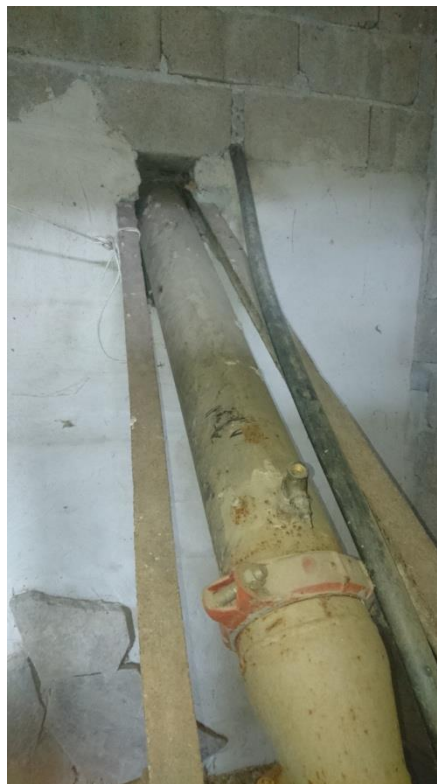
Figure 77: Emplacement possible du débitmètre
