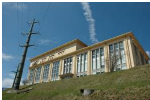
Figure 20 - Centrale hydroélectrique des Clées
