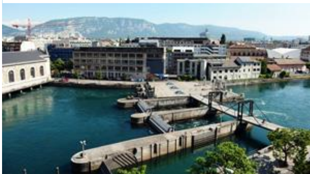
Figure 9 - Vue aérienne du barrage du Seujet
