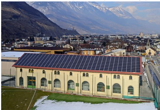
Figure 17 - Centrale hydroélectrique de Martigny
