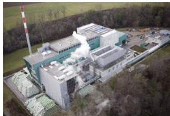
Figure 23 - Usine d'incinération de Posieux
