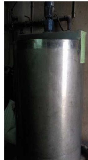
fig4 : cuve de polymère
