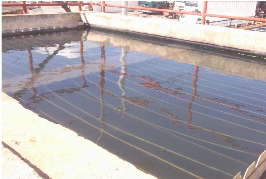
Fig 5 : bassin de décantation
