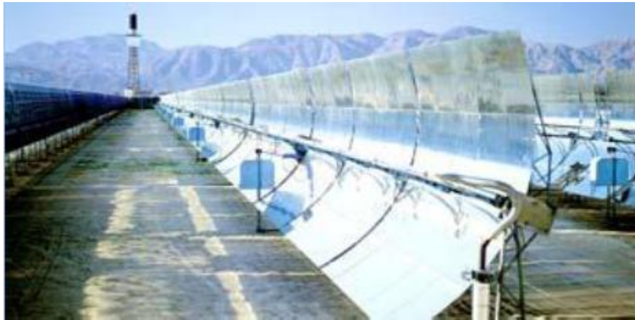
Figure 7 : Centrale thermique avec capteurs cylindro-parabolique [5]
