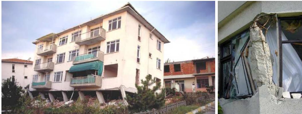
FIGURE 1.9: Exemples de ruptures localisées
