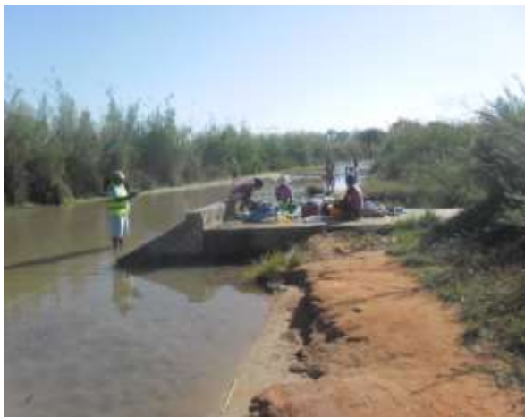
Figure 5 : Restes d'ancien dalot – La moitié de l'ancienne route a disparu (PK 224+150)
