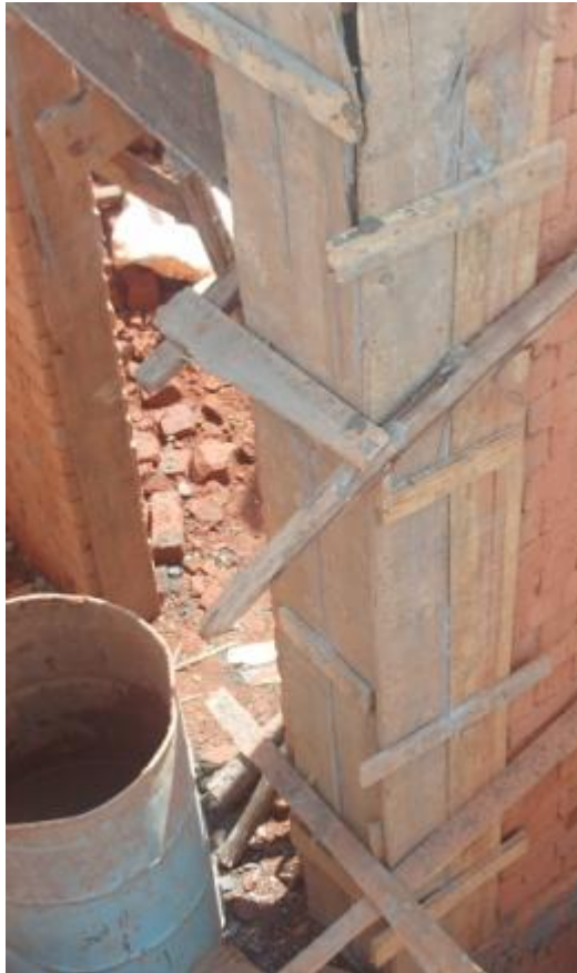
Photo 3. Coffrage du poteau après coulage du béton
