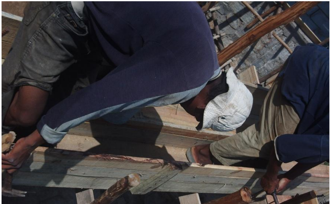
Photo 4. Préparation du coffrage de la poutre
