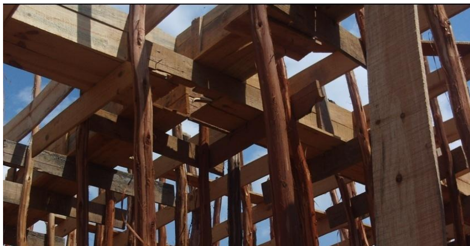
Photo 5. Préparation du coffrage de la dalle
