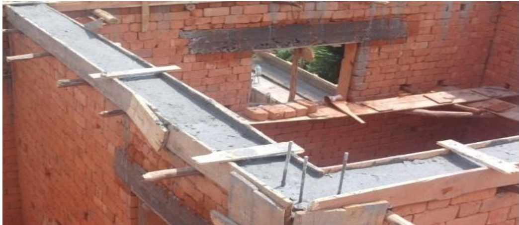
Photo 8. Chainages après coulage du béton
