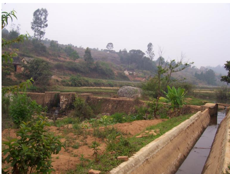
Photo n°12 ANTETEZAMBATO : Barrage à double emploi, pour l'irrigation et pour le fonctionnement de la Centrale Microélectrique (cliché de l'auteur).
