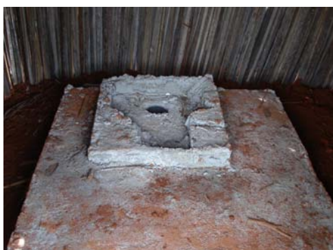
Figure 15 : Intérieur d'une latrine en cours de construction
