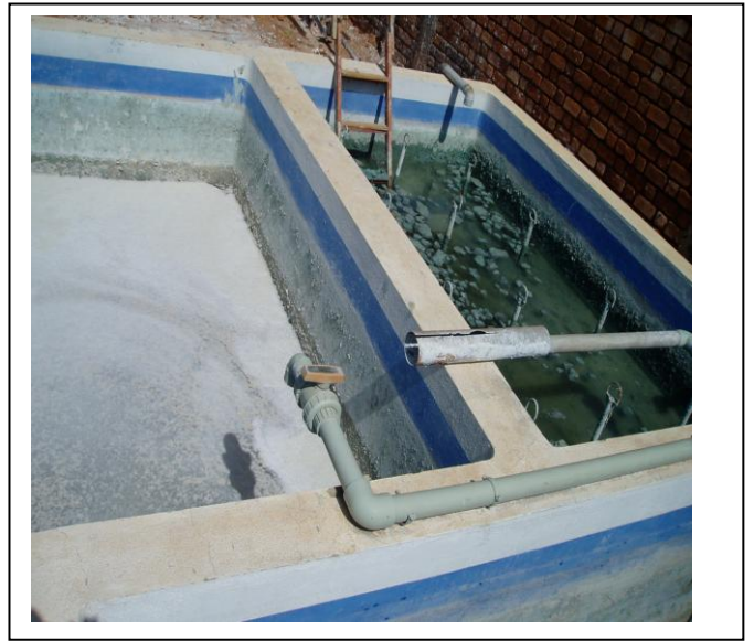
Figure n°19: Epaississeur de boue
