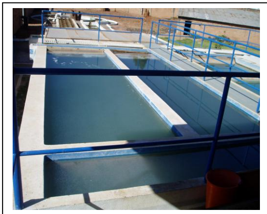
Figure n°12: Bassin de décantation
