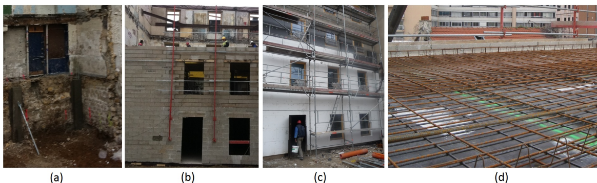
FIGURE 4.5 – Matériaux logement ITE. (a) mur en moellon et colonnes en béton (façade sud); (b), (c) mur en parpaing sans et avec isolation en polystyrène (façade nord); (d) armature en acier pour dalle en béton. Source : EQUATEUR Architecture
