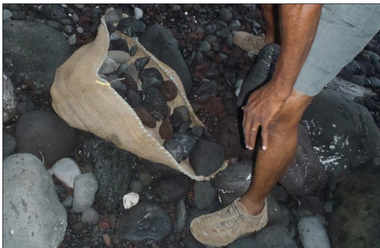
Photo 21. Démonstration à sec de la pose d'un goni, octobre 2014, rivière de Langevin, @Thomas
