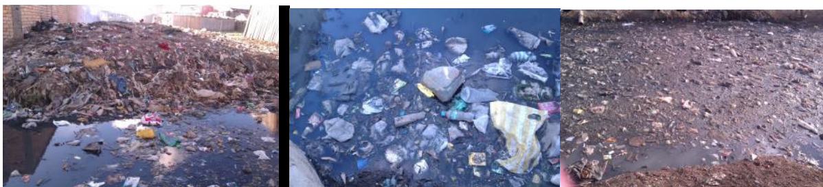
Figure 20. déchets plastiques/ partie obstruée de canaux d'évacuation d'Andriantany.
