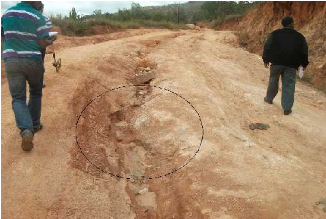
Figure 6 : Ravinement longitudinal au PK 116+600
