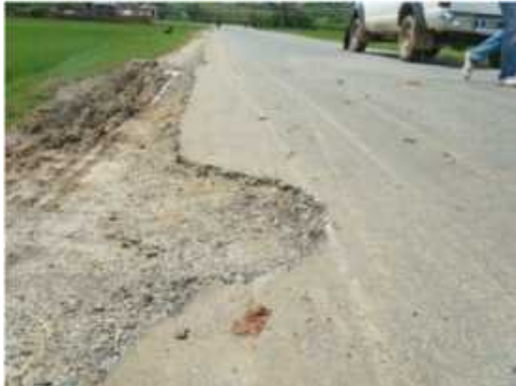
Figure 8 : Epaufure de Rive au PK 125+210
