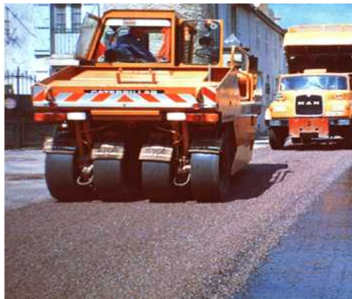
Figure 23 : Compactage de la Couche de Roulement
