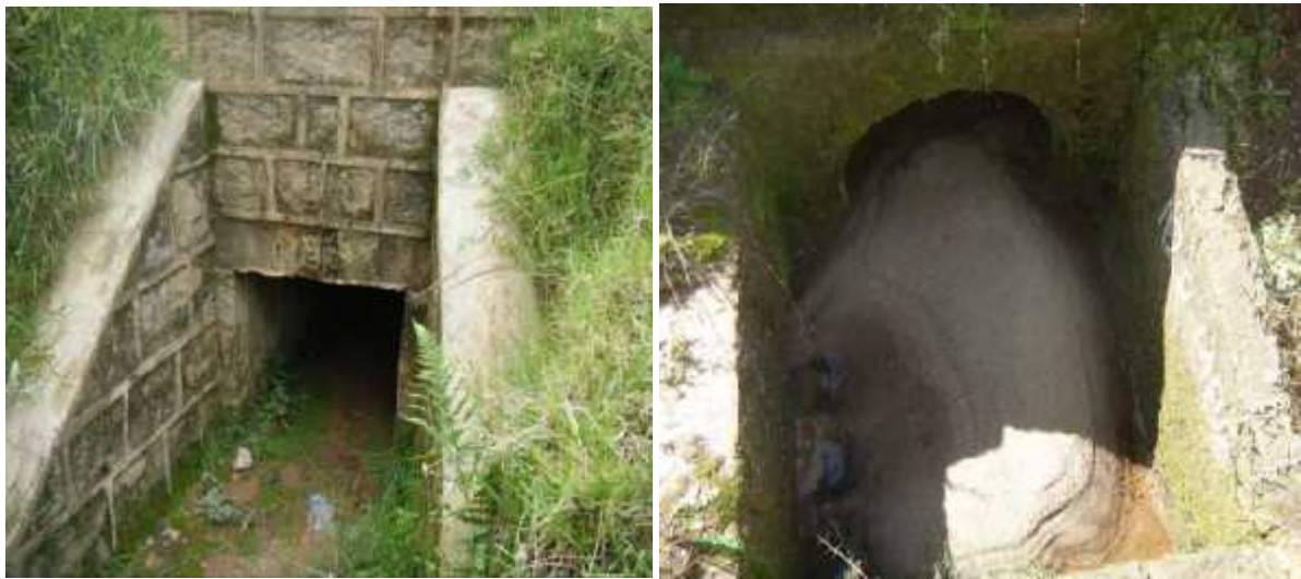
Figure 11 : Dégradations de dalot et buse PK 117+870
