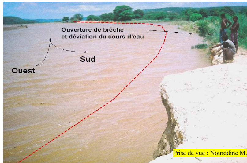
28 : Rupture de la route reliant Miary et le pont du Belalanda (2006-2007)
