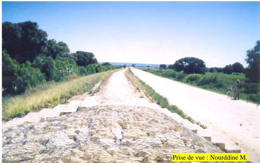
3 : La digue protégée par de neem, vétiver, sisal et acacia
