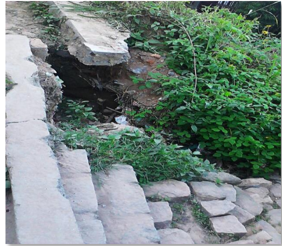
Photo n°4. Dispositif de collecte d'eau de surface détérioré ; année de photographie : 2016
