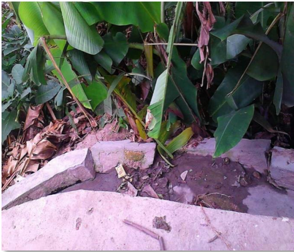
Photo n°3. Dispositif de drainage d'eau de surface détérioré ; année de photographie : 2016
