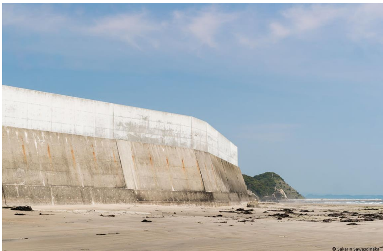
Figure 9 Exemple de mur de marée au Japon en réponse aux risques accrus de tsunamis dévastateurs liés à l'élévation du niveau des océans
