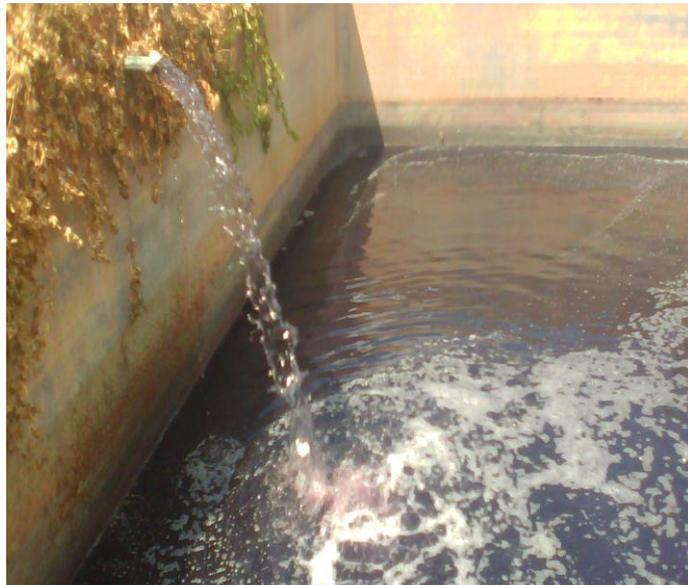
Figure 8. Bassin d'homogénéisation
