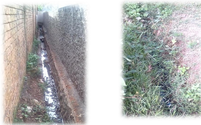
Photo 2: Canal d'évacuation des eaux usées existant
