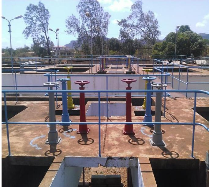
**Figure 16 : Les différentes vannes de lavages**
