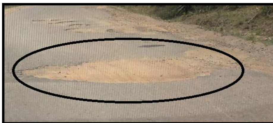
Figure 8. Nid de poule route revêtue au PK 389+030.
