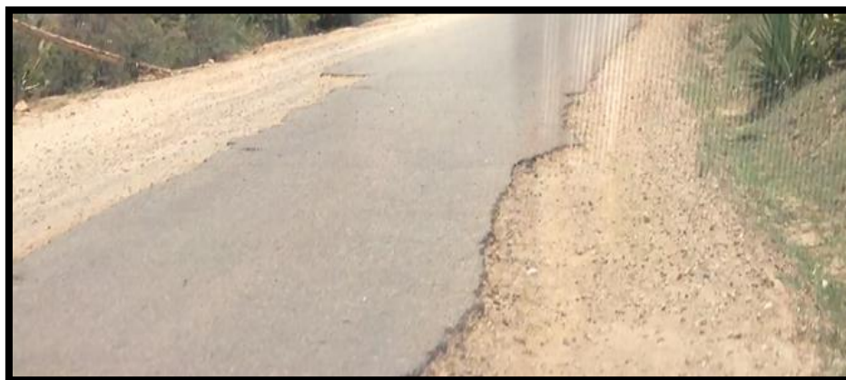
Figure 11. Arrachement généralisé de la couche de revêtement au PK 388+105.
