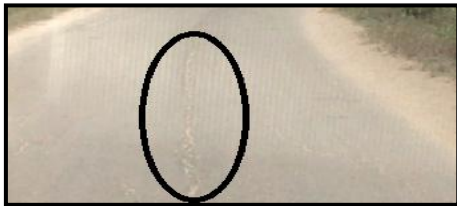
Figure 6.Fissure longitudinale au PK 385+200.
