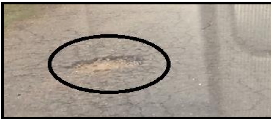
Figure 7. Faïençage entraînant un nid de poule au PK 386+750.
