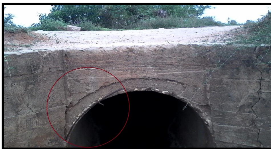
Figure 16. Buse avec des aciers apparents au PK 374+546.
