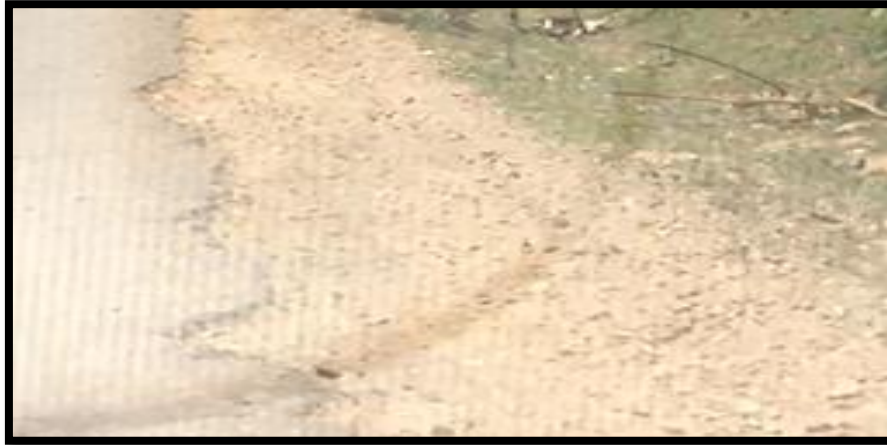
Figure 9.Epaufrure de rive au PK 387+325.
