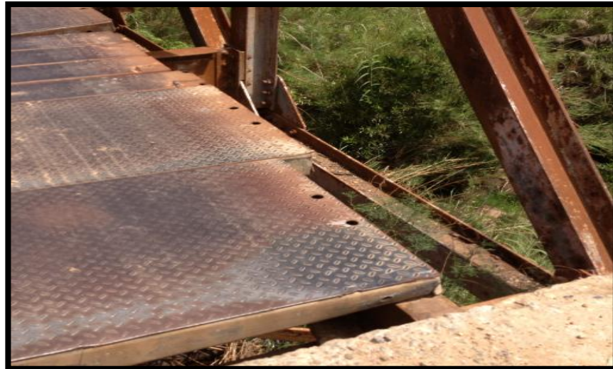
Figure 12. Pont métallique dégradé au PK 387+025 .
