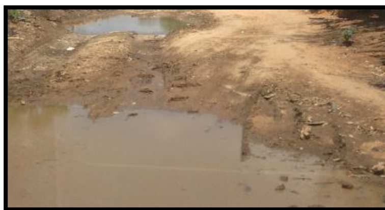
Figure 5. Nid de poule route en terre au PK 374+156.
