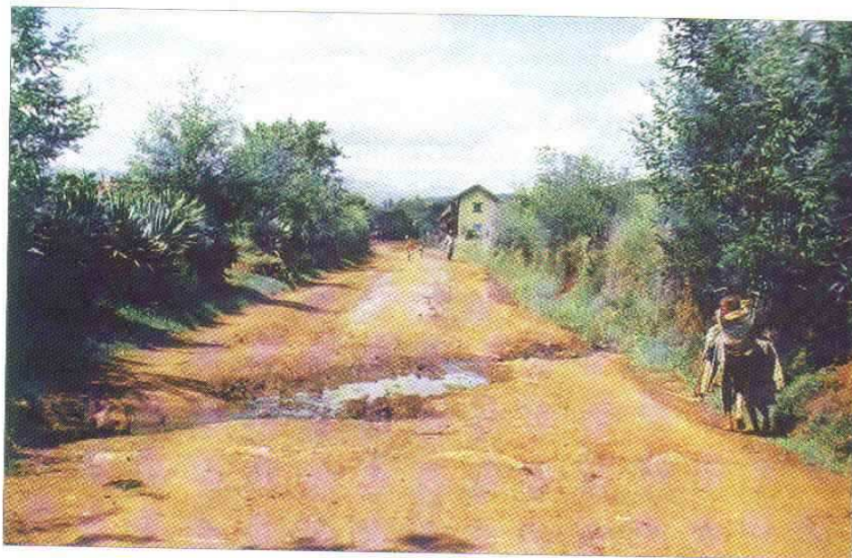
Photo 14.6: Ravinement longitudinal dû à un mauvais assainissement
