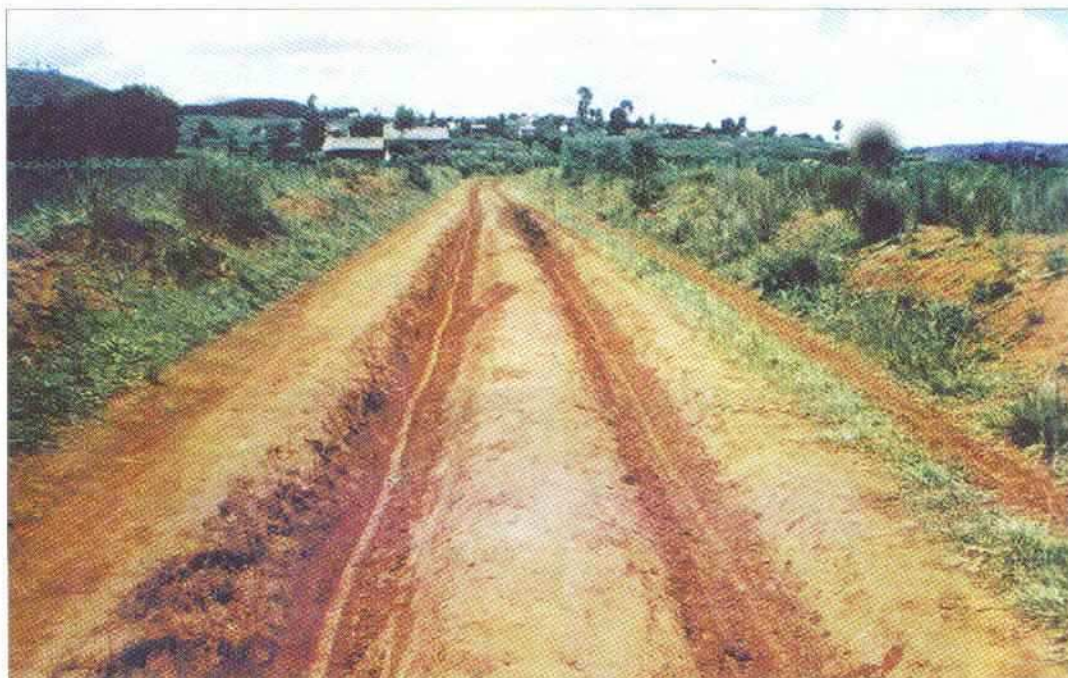
Photo 14.3: Dégradation de la route - Ornières causées par les charges des charrettes et des camions
