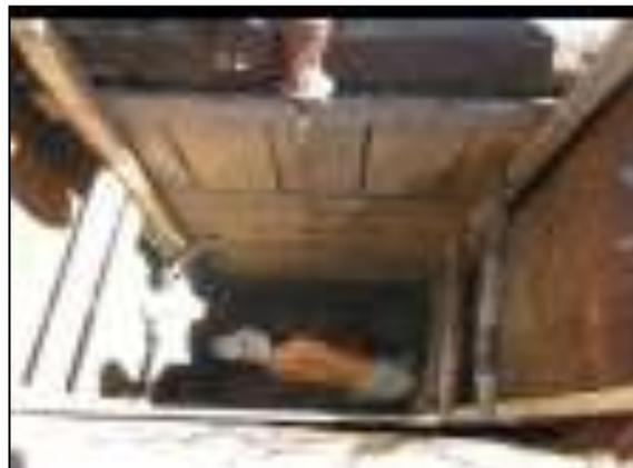
photo 23: Soutènement en bois pour un puits
