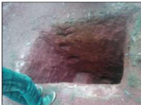
photo 10: Puits creusé par les orpailleurs
