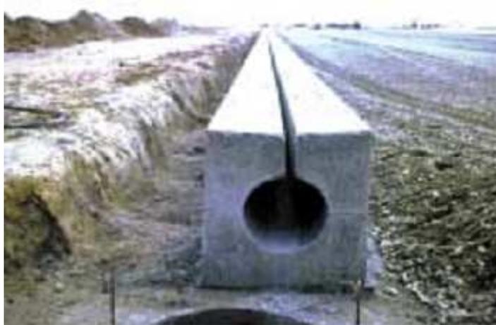
**Figure 35:** Drain d'évacuation
