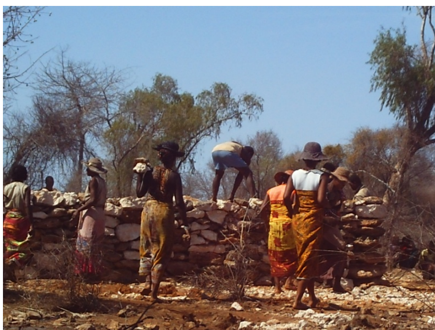
Photo n°1: Travaux de couverture en pierre du tombeau après l'enterrement
