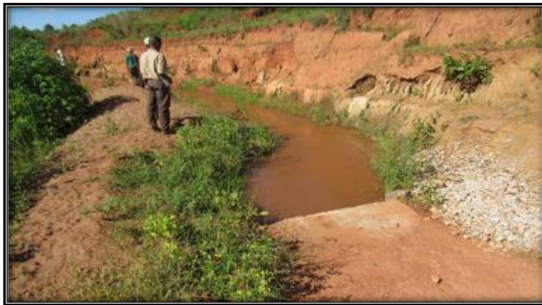
Photo 3: Canal principal couvert en état de glissement et déviation de son parcours
