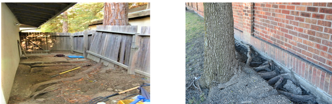
FIGURE 2.8 – Racines d'arbres se développant sous des bâtiments.
