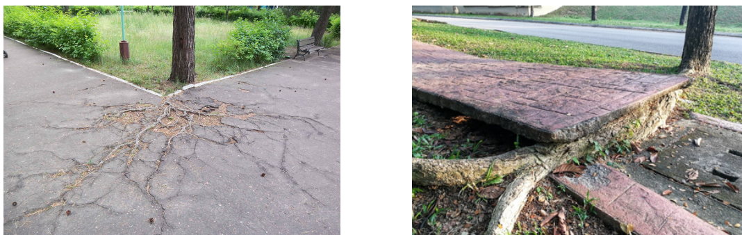
FIGURE 2.10 – Dommages causés par les racines aux chaussées en milieu urbain.
