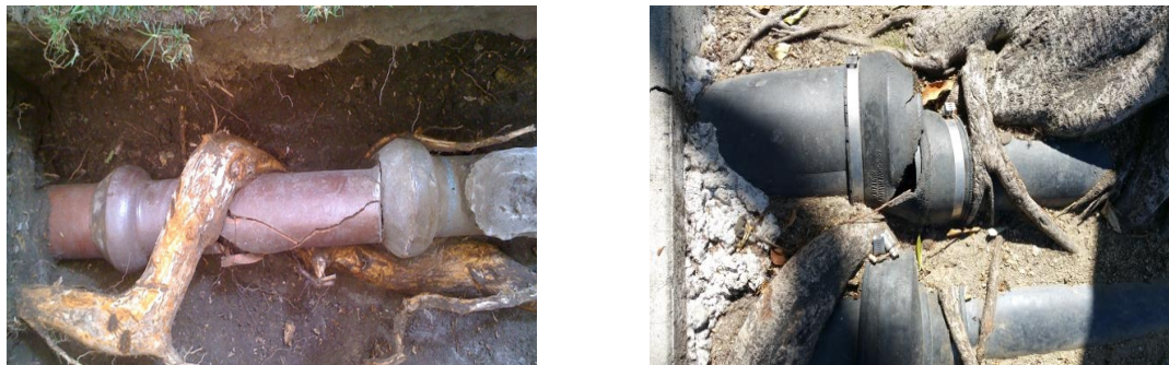
FIGURE 2.9 – Dommages causés par les racines aux canalisations.
