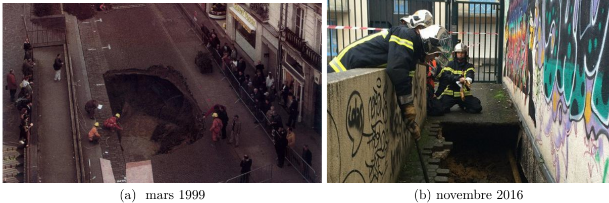
FIGURE 1 – Effondrements dans des chantiers de tunnels de métro à Rennes ( France Info )
