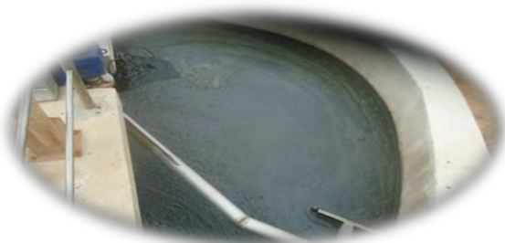
Photo n°3 : Dégrilleur + dessableur/déshuileur, prise par Bienvenu .A. Sagna
