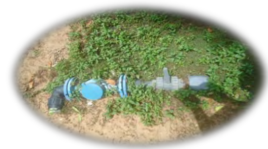
Photo n°13 : Compteur (non opérationnel) installé pour relever le volume des eaux usées épurées, prise par Bienvenu A. Sagna
