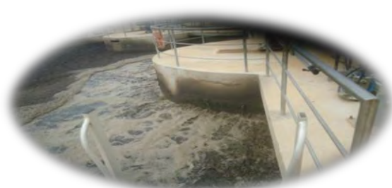
Photo n°5 : Un réacteur biologique, prise par Bienvenu A. Sagna
