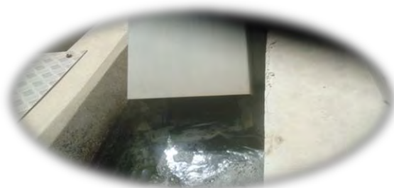
Photo n°3 : Dégrilleur + dessableur/déshuileur, prise par Bienvenu .A. Sagna
