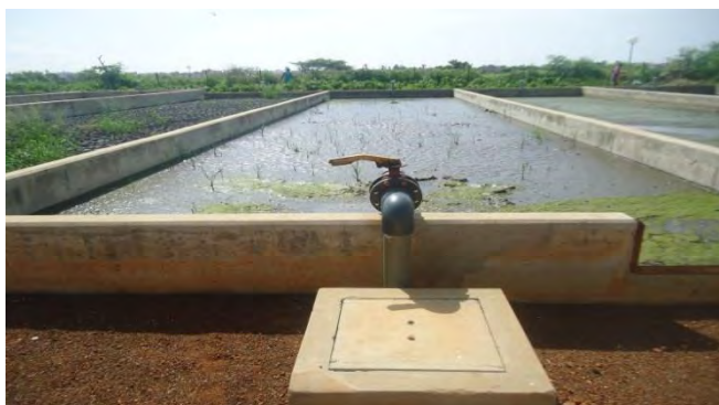
Photo 21 : Lit de séchage à boue
