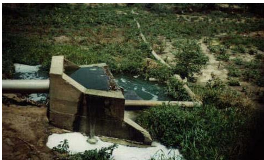
Photo n°7 : Emissaire de Saly Portudal : tuyau de captage pour zone de réutilisation
