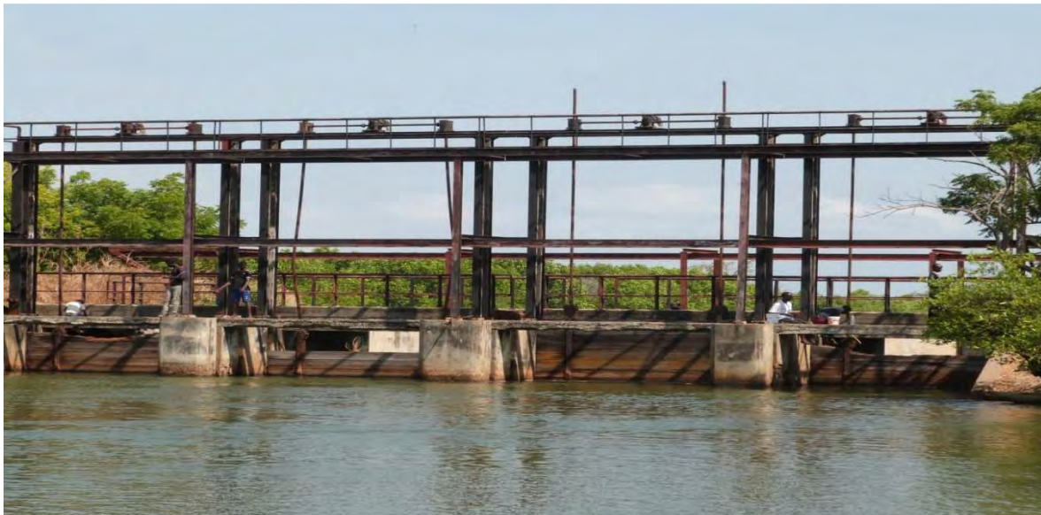
Photo 5 : Barrage anti-sel de Guidel : les vannes sont fermées (Marie T. Gomis Décembre 2013)
