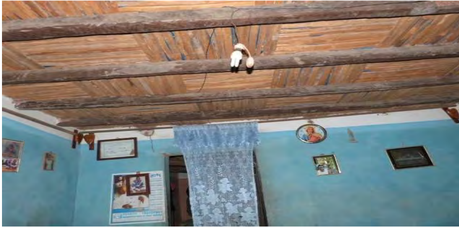
Photo 16 : Plafond d'une chambre à partir des branches de rôniers (Auguste Preira, octobre 2013)
