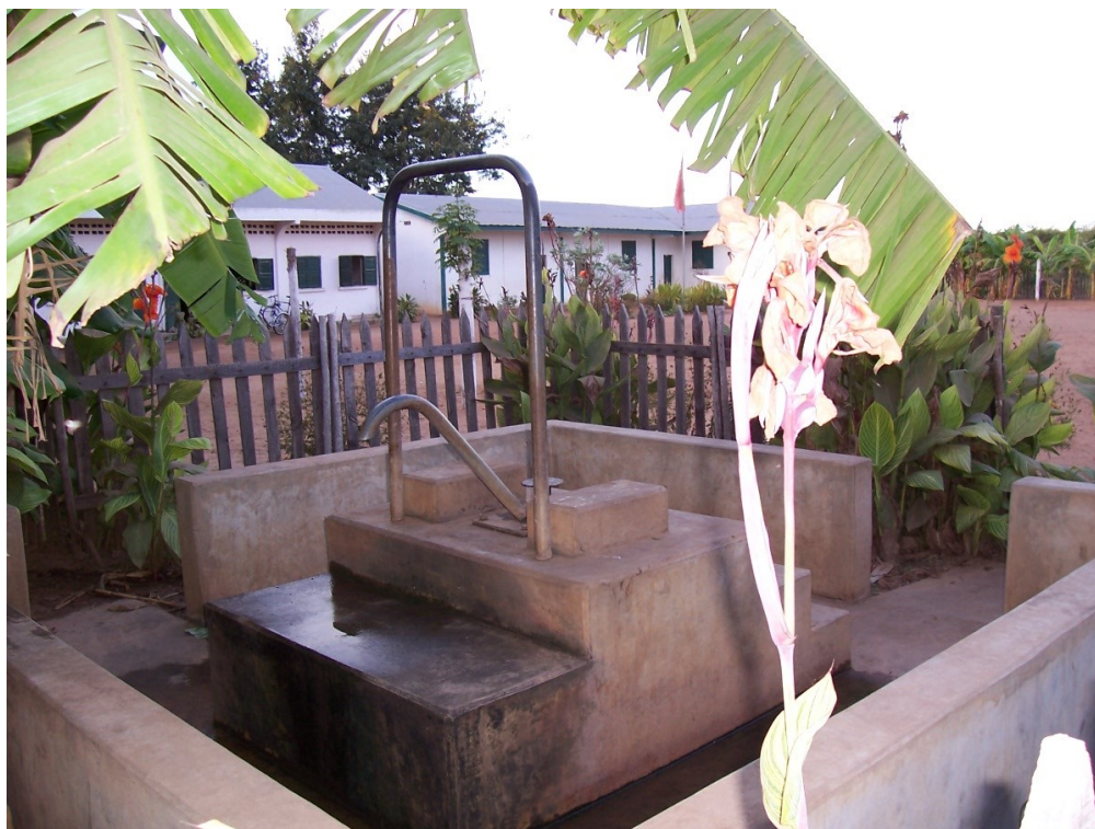
Photographie 2. Forage à levier - Site Croisement Belo sur Tsiribihina
