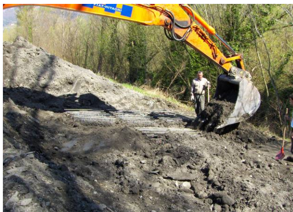
Photo II.18 : Remblaiement de la zone
