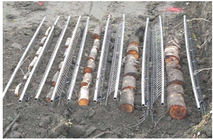
Photo II.15 : Mise en place des paniers
