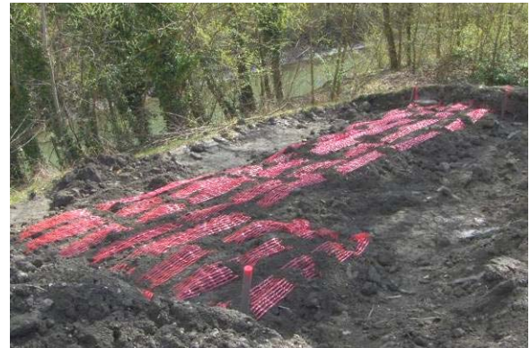
Photo II.17 : Mise en place du grillage avertisseur
