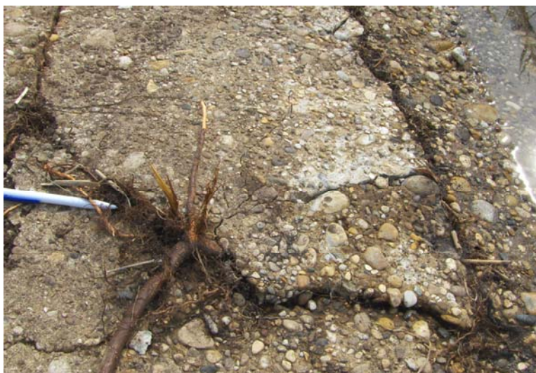
Figure IV.3 : Dégradation du perré par colonisation d'une fissure par les racines (digue de canal du Rhône)
