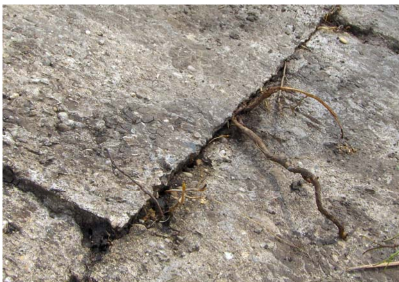
Figure IV.2 : Colonisation par les racines d'un joint de perré bétonné (Digue de canal du Rhône)
