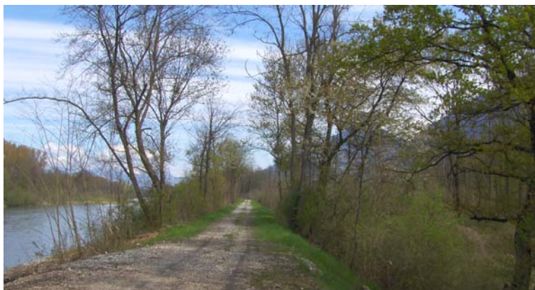
Photo II.3 : Digue de l'Isère à Tencin
