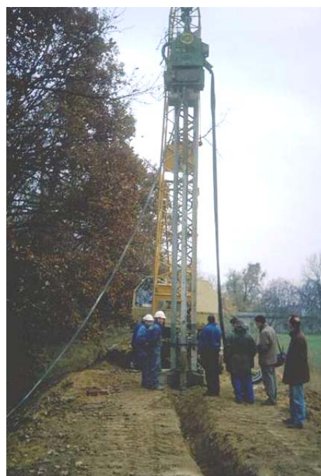
Figure IV.12 : Réalisation d'une paroi moulée (Digue en Pologne)
