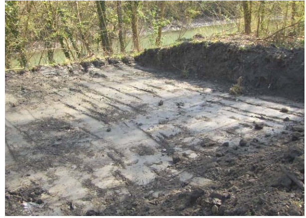
Photo II.13 : Terrassement de la zone expérimentale
