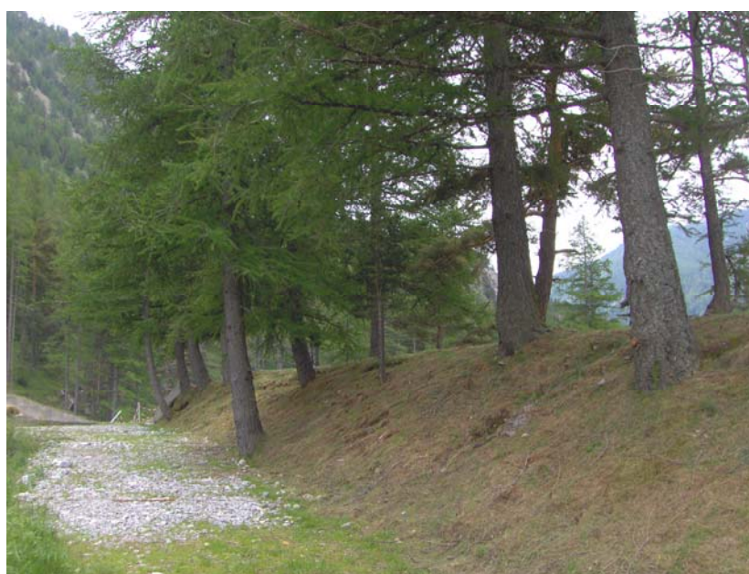
Photo II.5 : Digue de fermeture du barrage de Castérino
