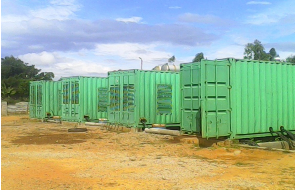
Photo 1.4 : Groupes électrogènes en container (Source : Auteur)
