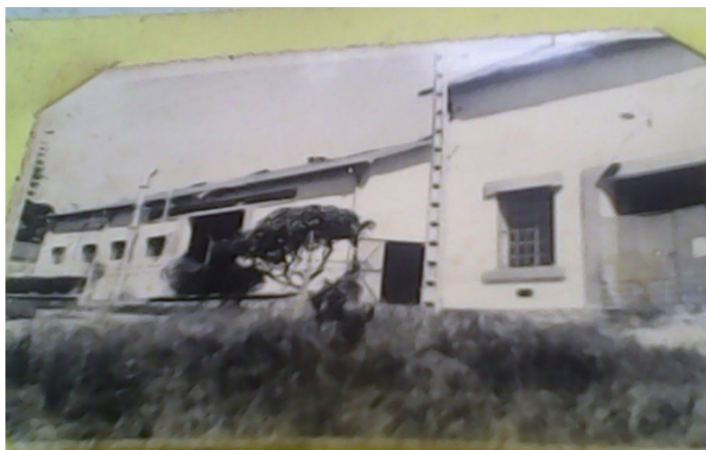
Photo 1.2 : Centrale Hydroélectrique MANANDRAY (Source : Auteur)
