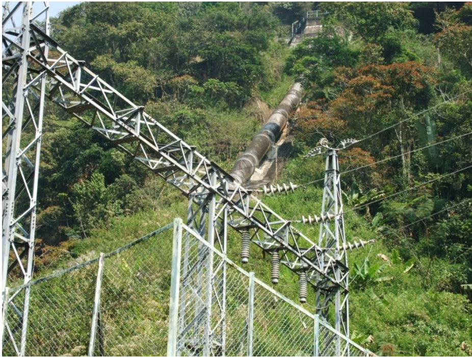
Photo 1.3 : Centrale Hydroélectrique AMBODIKIMBA (Source : Auteur)
