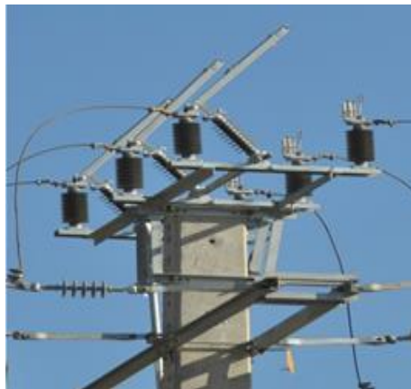
Fig. 2.13 : Interrupteur aérien types IACM
