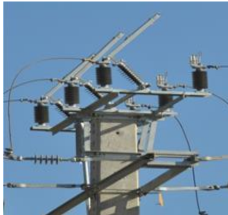
Fig. 2.13 : Interrupteur aérien types IACM
