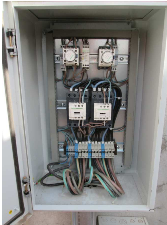
Figure 15 : Inverseur électromécanique avec relais temporisateur [1]
