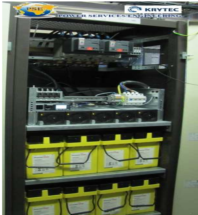
Figure 16 : baie système 48VDC [4]
