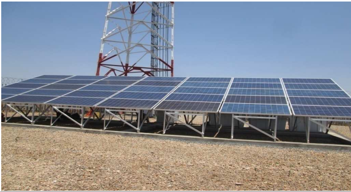
Figure 8 : Site à alimentation solaire photovoltaïque autonome [1]
