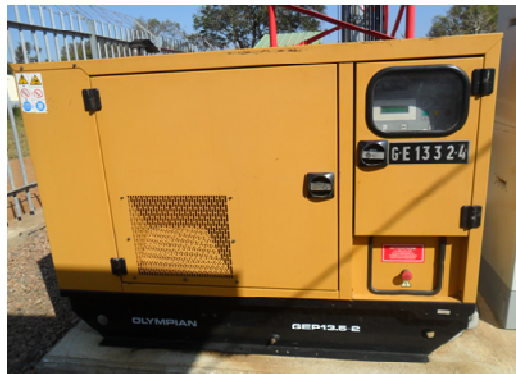
Figure 13 : Groupe électrogène OLYMPIAN 13.5kVA
