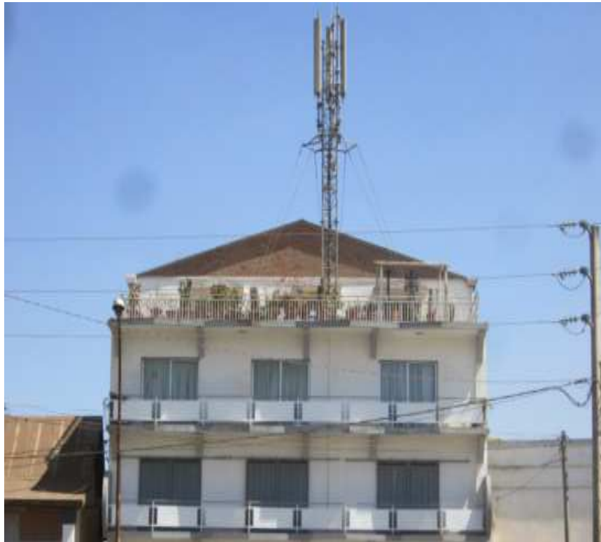
Figure 25 : Site de type Roof Top
