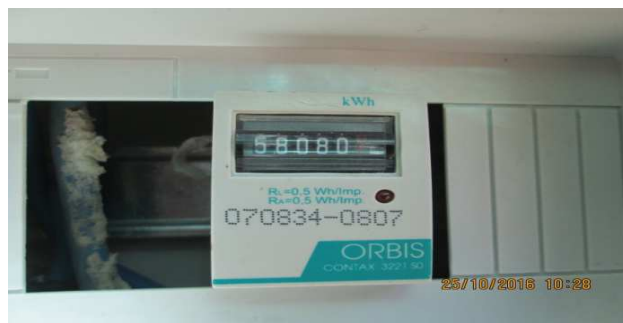
Figure 28 : Sous compteur [1]
