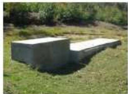
**Photo 8 : La chambre de mise en charge.**
