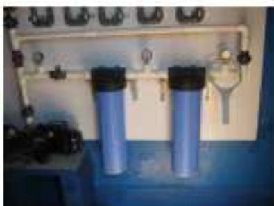
**Photo 19 : Les filtres carbones ou micro-filtres.**
