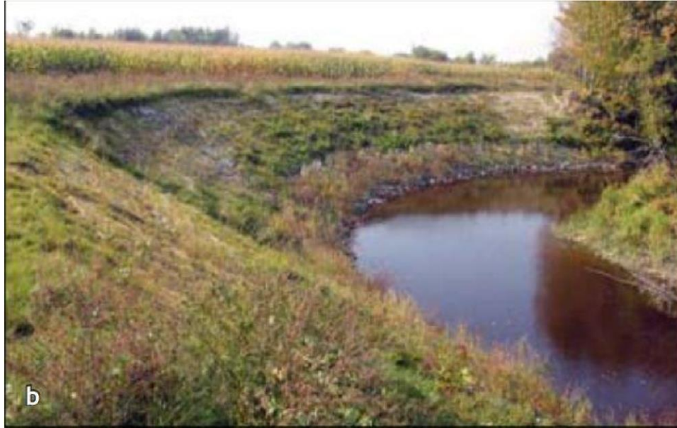
Figure 11 : Protection de berge par une végétalisation
