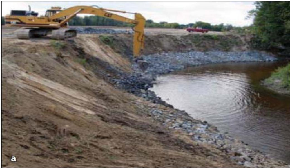
Figure 10 : Protection de la berge par un empierrement ;
