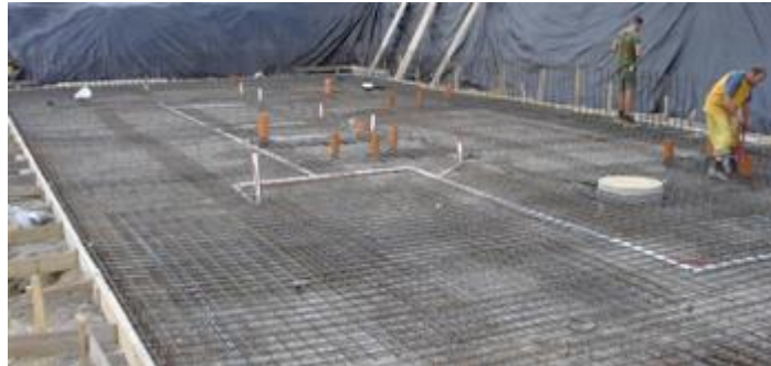
Figure 14: Pendant la mise en place des armatures
