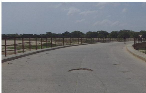
Photo 9 Nids de poule sur le pont Fiherenana
