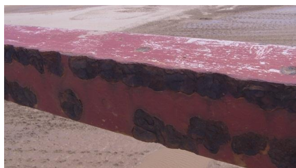
Photo 13 Corrosion des garde-corps
