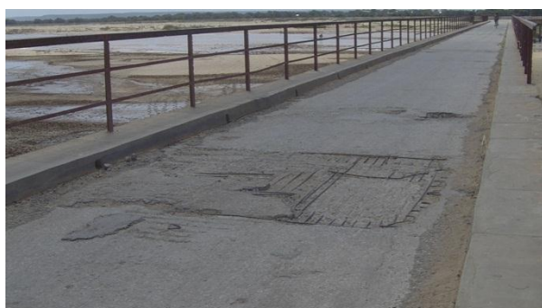
Photo 12 Affaissement sur le pont
