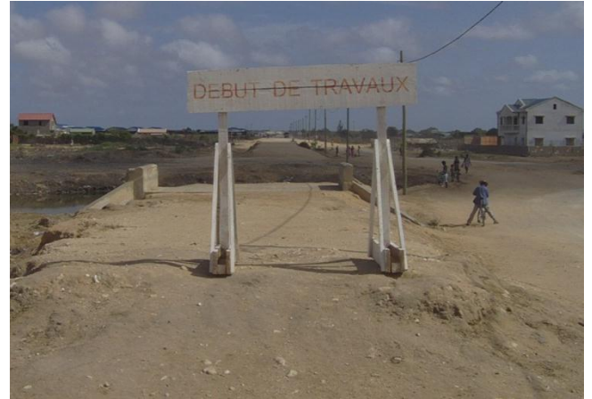
Photo 2 Début des travaux
