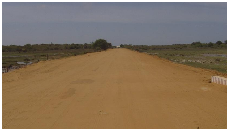
Photo 3 Remblai et couche de fondation effectué
