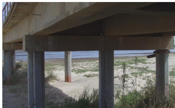
Photo 10 Fondation du pont Fiherenana
