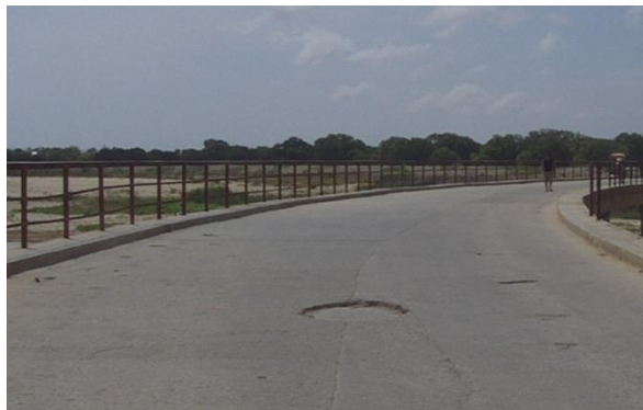
Photo 9 Nids de poule sur le pont Fiherenana
