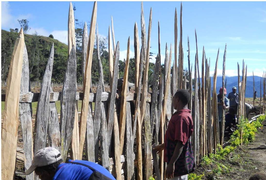
La construction de la barrière autour de l'estrip (05/13)
