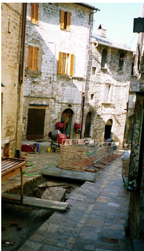
Cliché 5.9. Travaux systématiques d'enterrement des réseaux de fils et conduits dans une rue à Assise.
