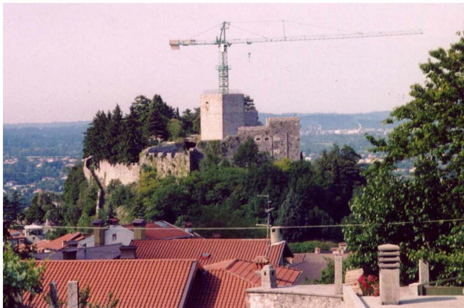
Cliché 5.19. La reconstruction du château de Gémone.
