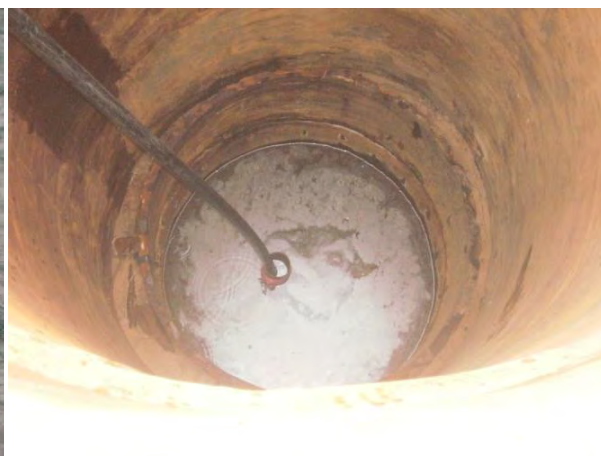
Photos 5 et 6 : Coloration des arrosoirs et de bassin par effet de salure des eaux
