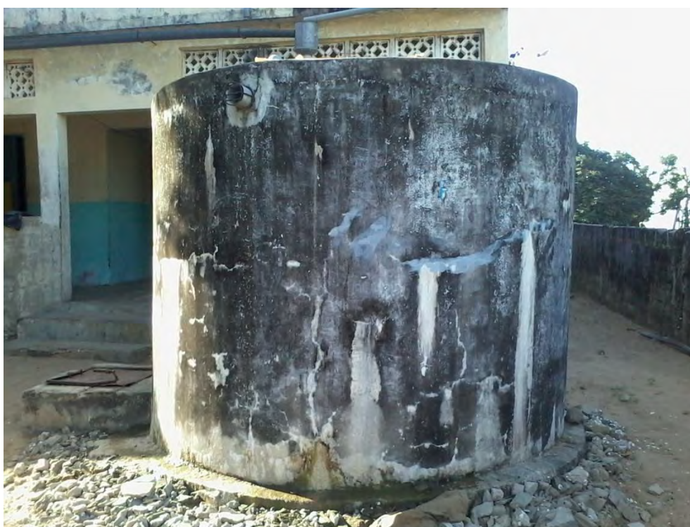
Photo 6 : Ouvrage de collecte d'eau pluviale à Moundé (Novembre 2013, ND. F.DIOP)
