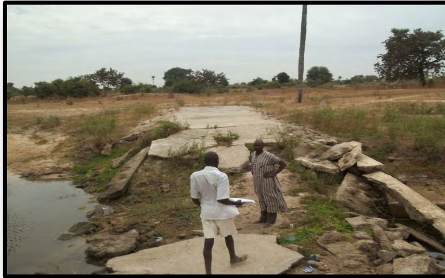
Photo 14: Une partie de la digue antiérosif de Nobandane est emportée par les eaux de ruissellements
