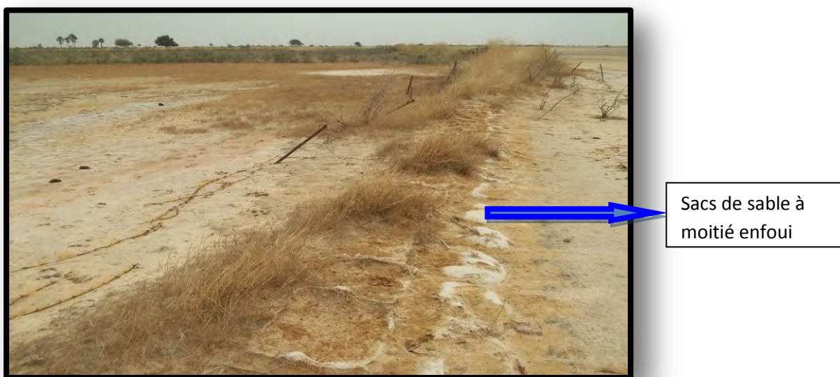
Photo 12: Diguettes de sacs de sable fixées par Sporobulus robustus à Sakhor
