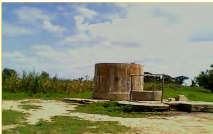
**Photo 2 : Exemple d'un forage doublé d'un puits à exhaure manuelle**
